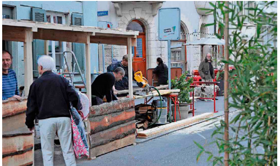
Die Aufbauarbeiten für die erste Adväntsgass in Basel sind bereits in vollem Gange.
